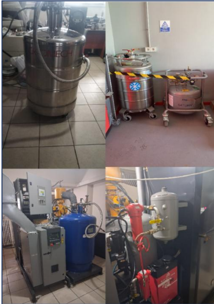
Şekil 38. DIRAC için Sıvı Azot Temini.
