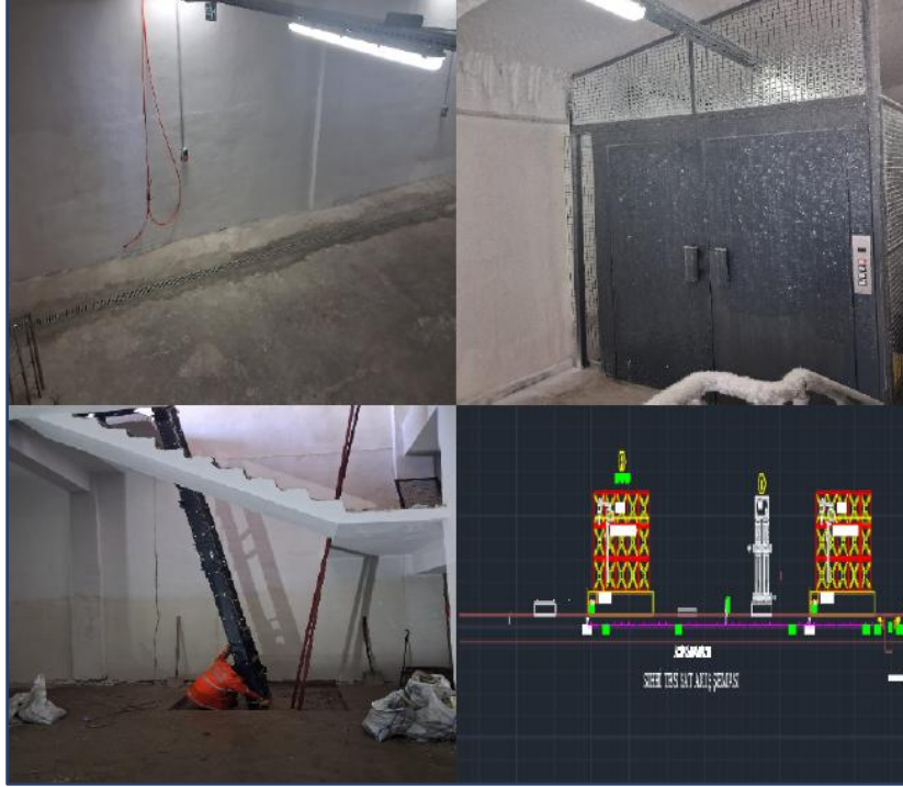
Şekil 34. DAG Yerleşkesi Yeni Su Deposu.
