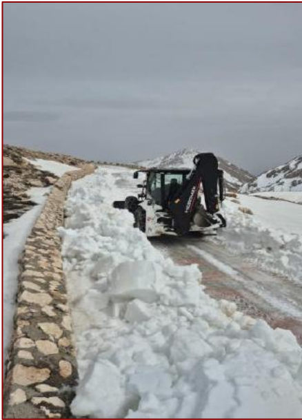
Şekil 28. Antalya TUG Yerleşkesi Yol Çalışmaları.
